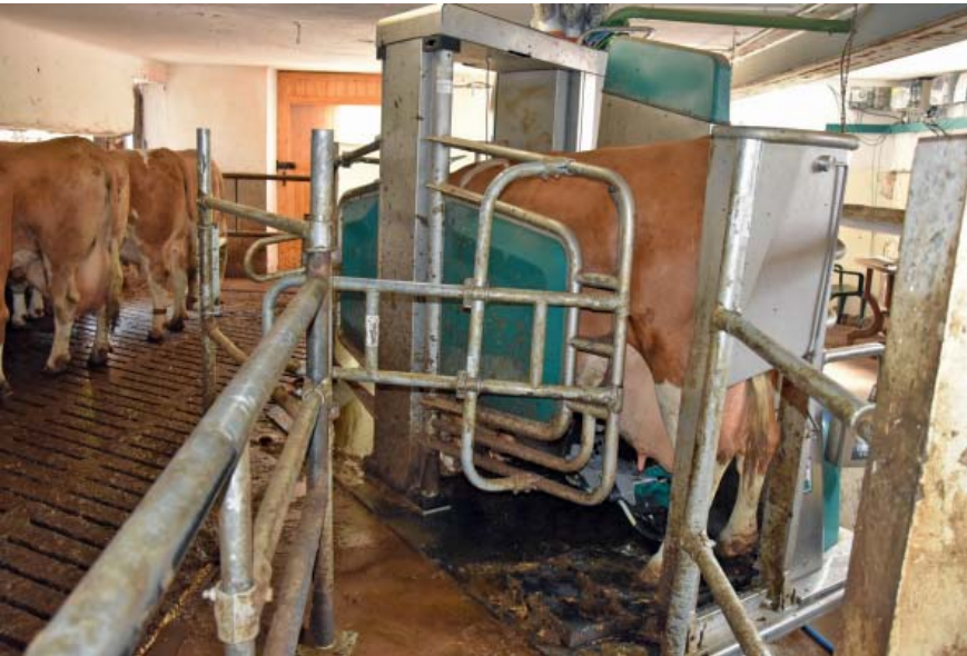
Bild 2: Gelungener, nachträglicher Einbau einer Melkbox am ehemaligen Melkstand.
